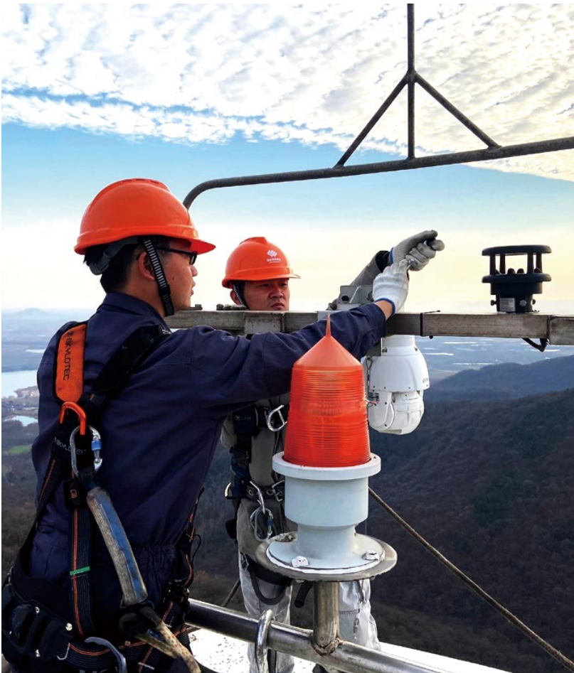
员工在风机机舱外安装全局摄像头
